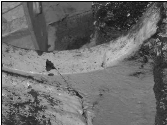
Slika 3: Prslina na gornjoj ploči donje gradnje
